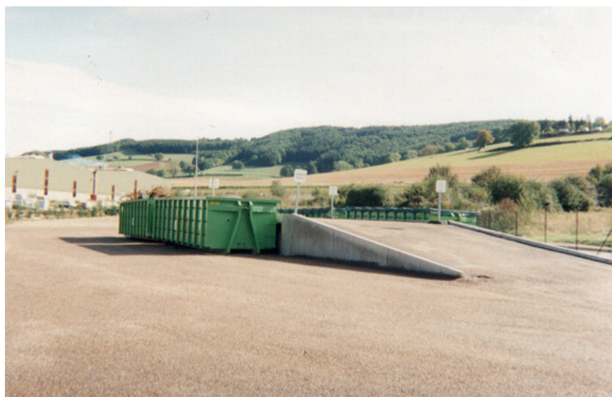
Rys. 8 Rampa wyładownicza zlokalizowana na terenie PDGO
