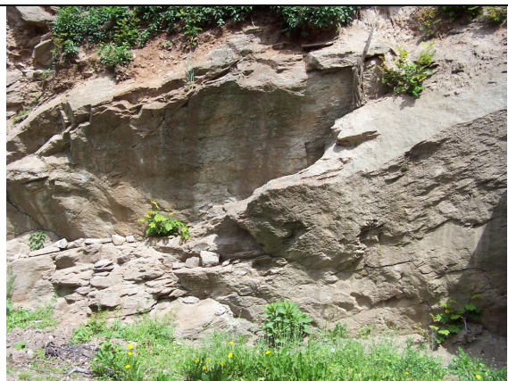
Fot. 2. Widoczne nacieki naskalne potwierdzające w okresach ekstremalnych przepływów wód opadowych i roztopowych po powierzchni skał.
