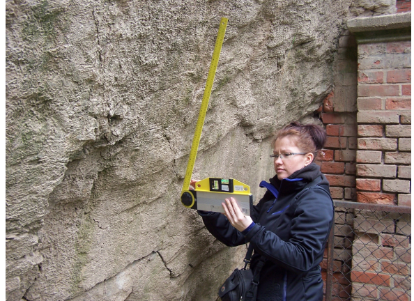
Fot. 6. Pomiar pochylenia bloku skalanego.
