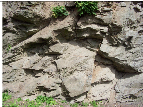
Fot. 8. Widok zwietrzałych skał grożących obrywom.
