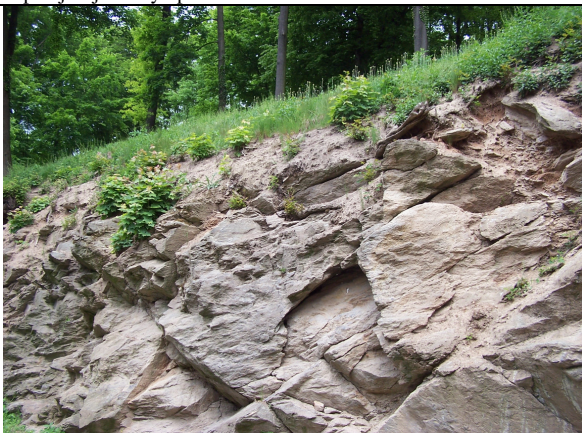
Fot. 7. Widok zwietrzałych skał grożących obrywom.
