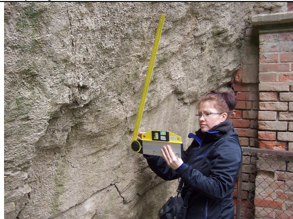
Fot. 6. Pomiar pochylenia bloku skalnego.
