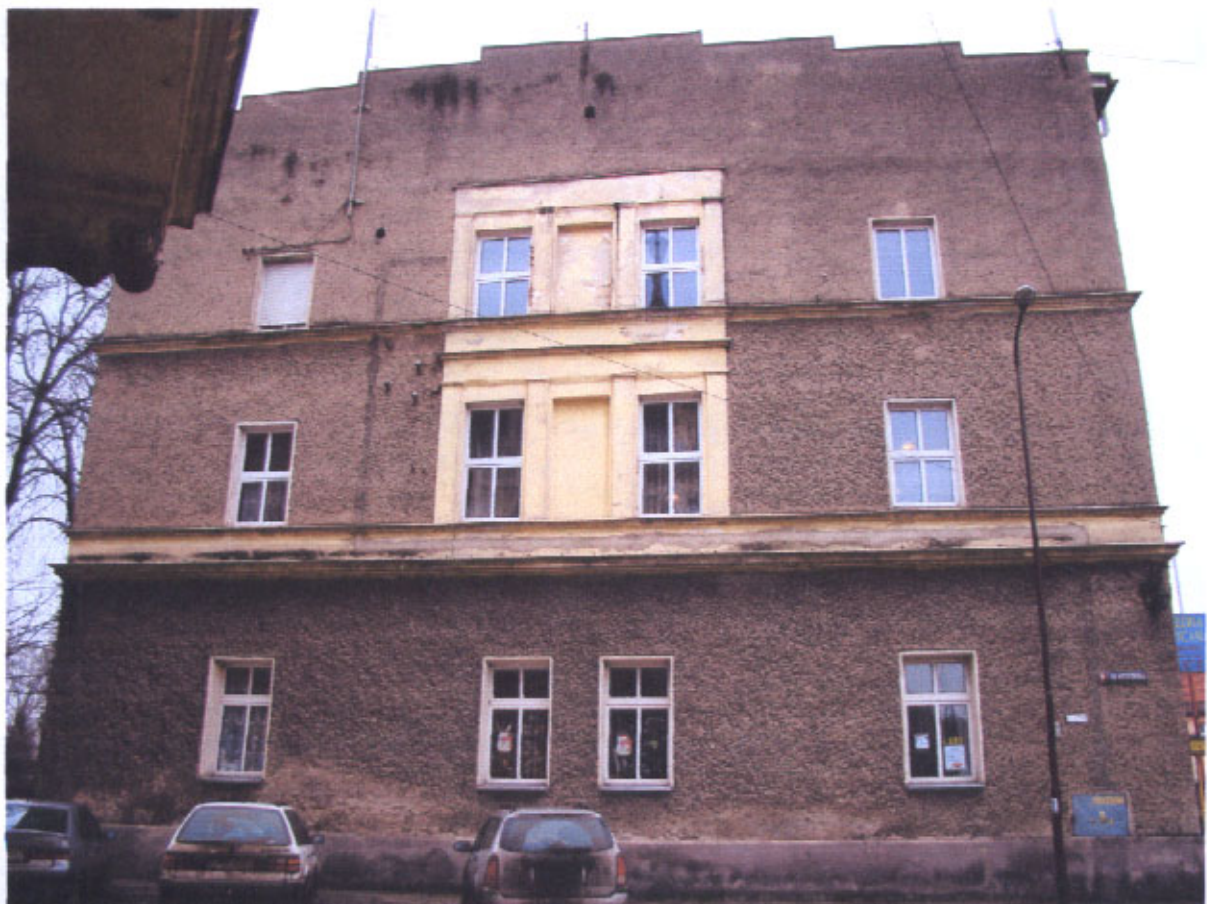
FOT. 2 – ELEWACJA BOCZNA – ZACHODNIA – stan obecny
