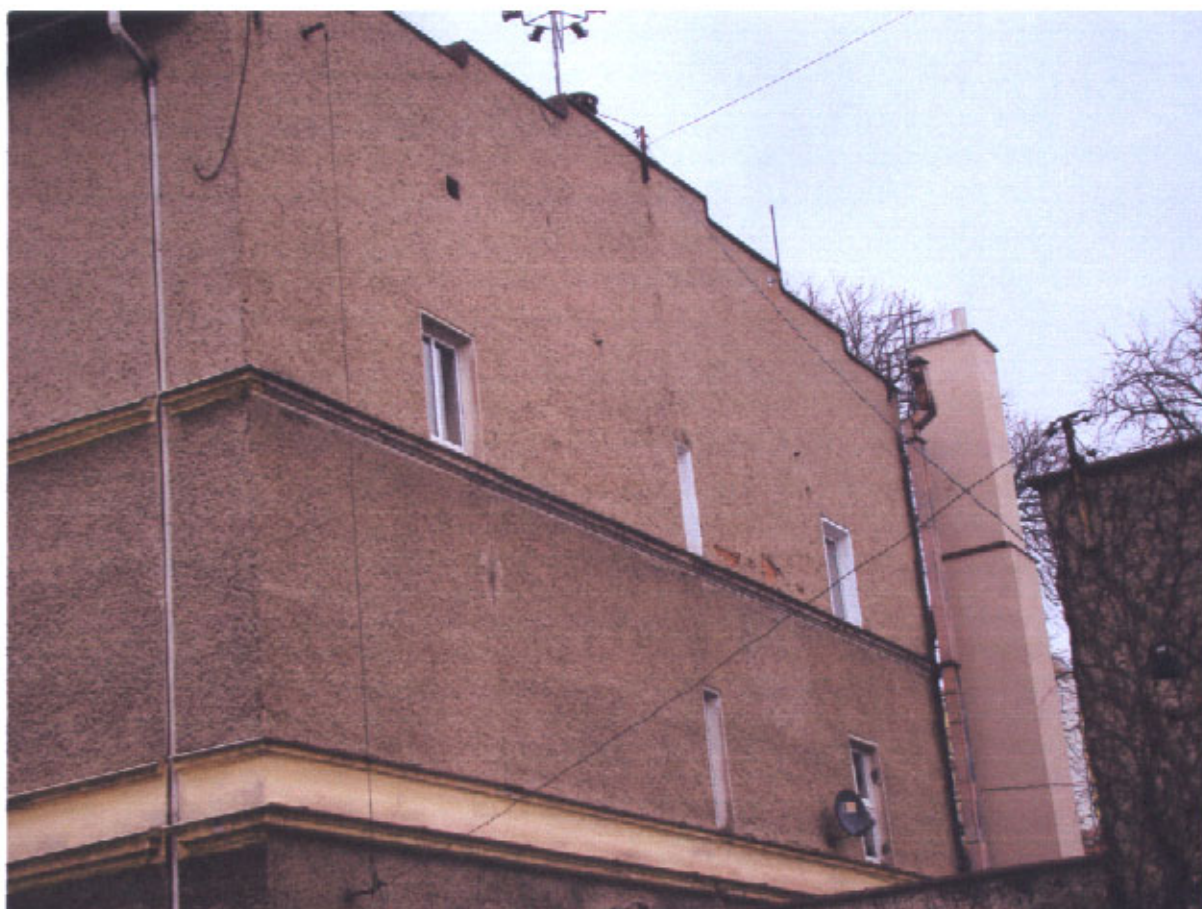
FOT. 4 – ELEWACJA BOCZNA – WSCHODNIA – stan obecny
