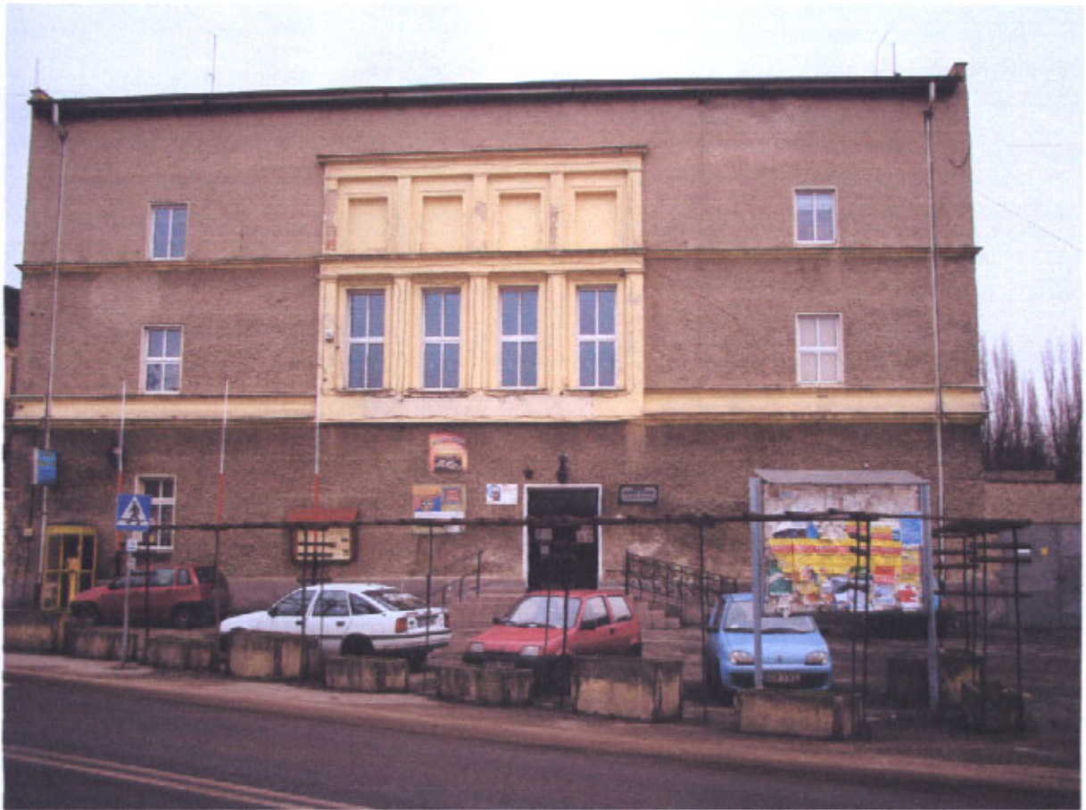
FOT. 1 – ELEWACJA FRONTOWA – POŁUDNIOWA – stan obecny
