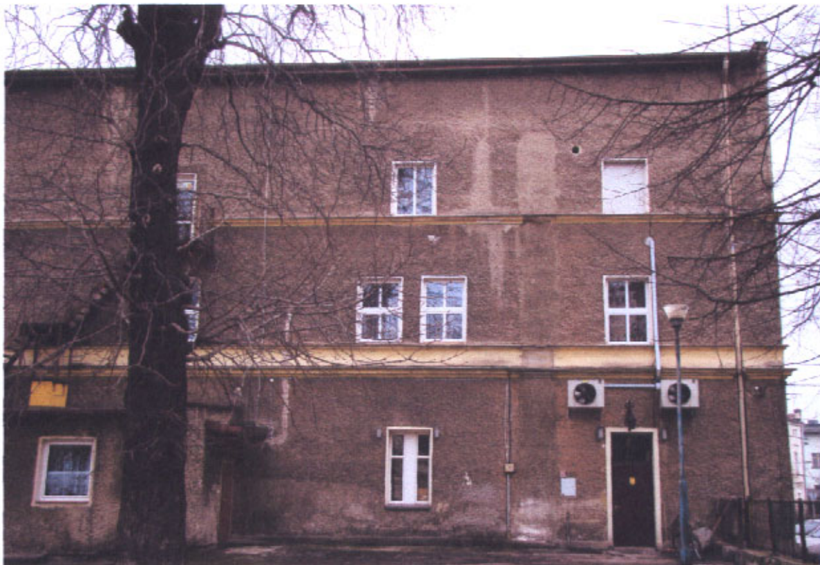
FOT. 3 – ELEWACJA TYLNA – PÓLNOCNA – stan obecny
